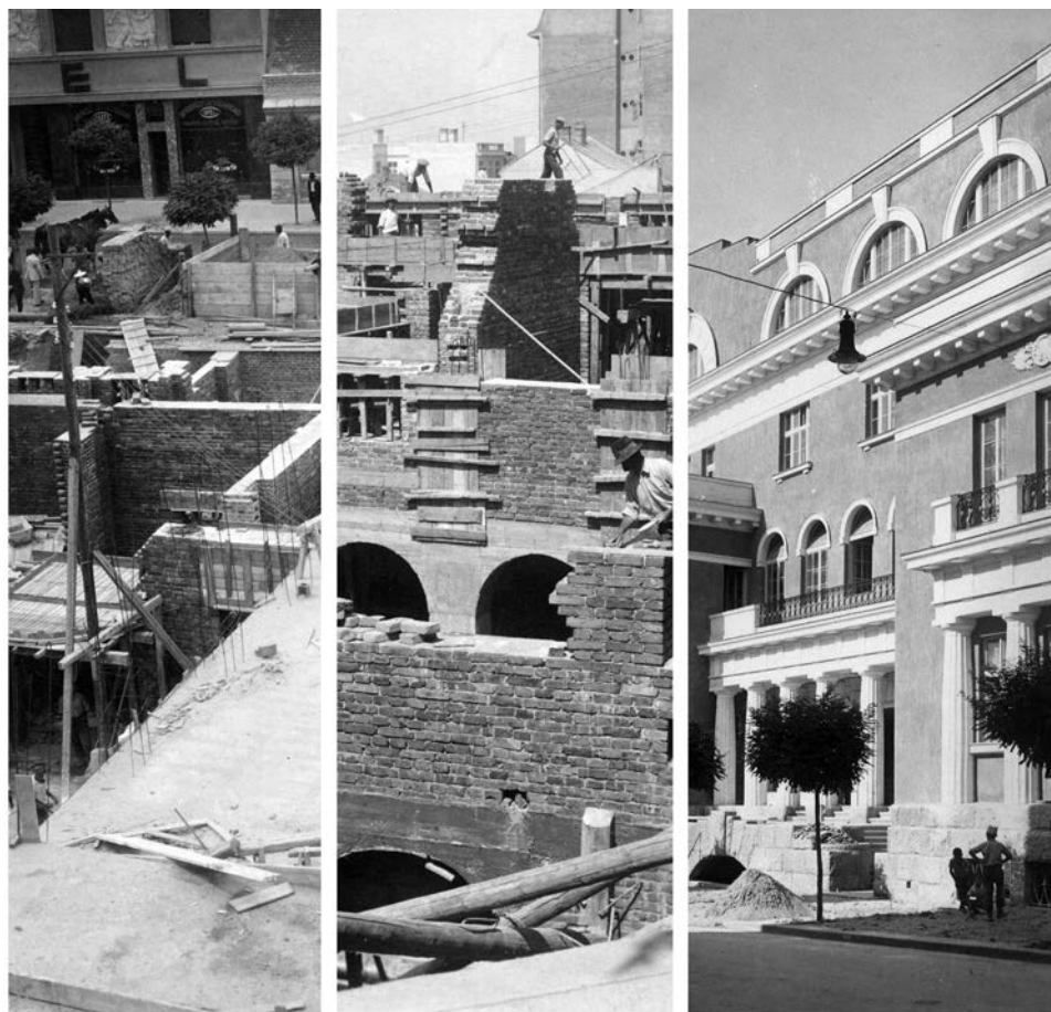
Строительство Русского дома в Белграде. Фотоколлаж
