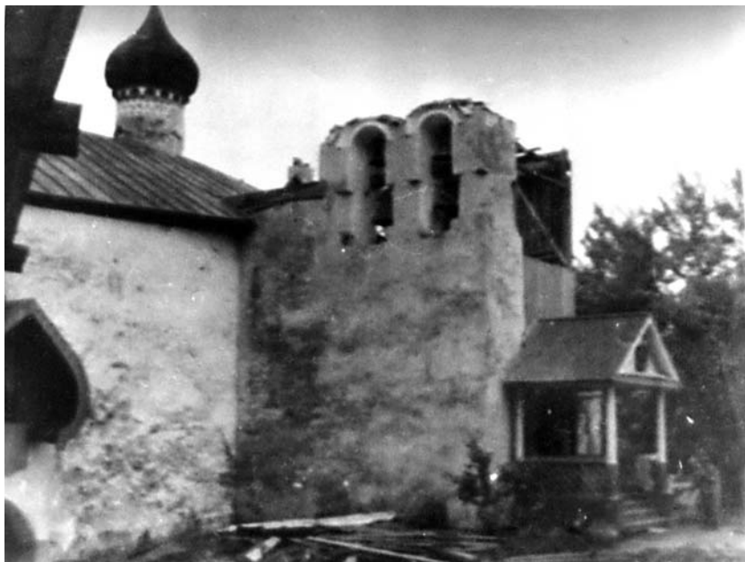
Реставрация церкви Николы Ратного Псково-Печерского монастыря. 1935 г.
